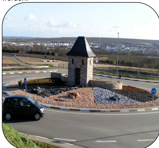
Die Umgestaltung von Wegen und Plätzen mit Bitumen- oder Betonbelag in Pflasterflächen
